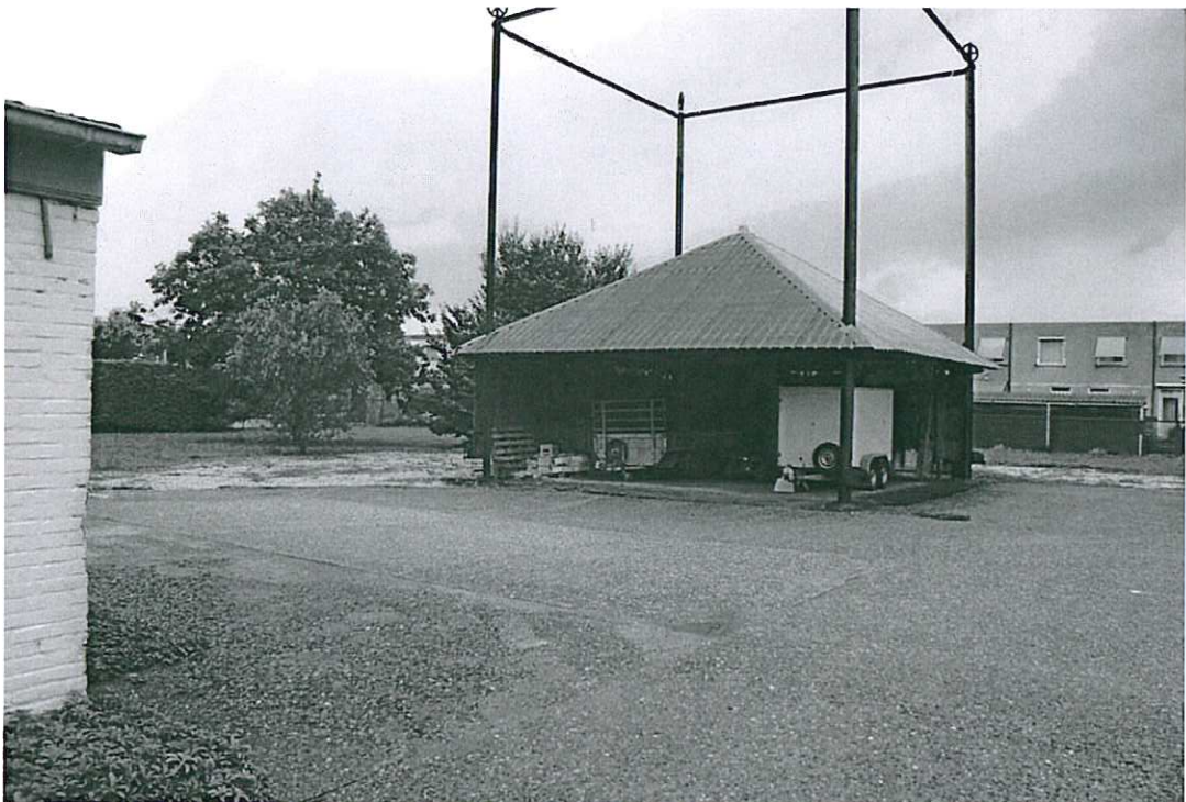
Foto 2: Gezicht vanuit zuidoostzijde op onderzoekslocatie.
