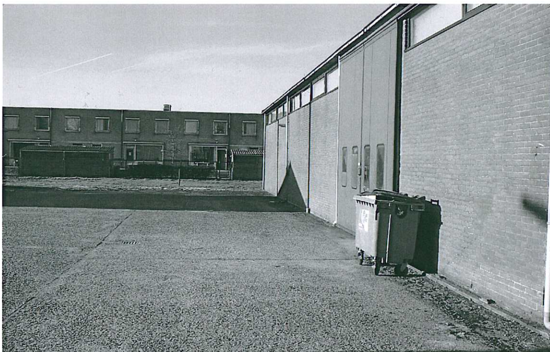
Foto 2: Gezicht vanuit zuidoostzijde op de landbouwschuur en de betonverharding.
