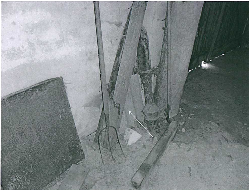
Foto 5: Gezicht op een stuk asbestverdacht golfplaatmateriaal.
