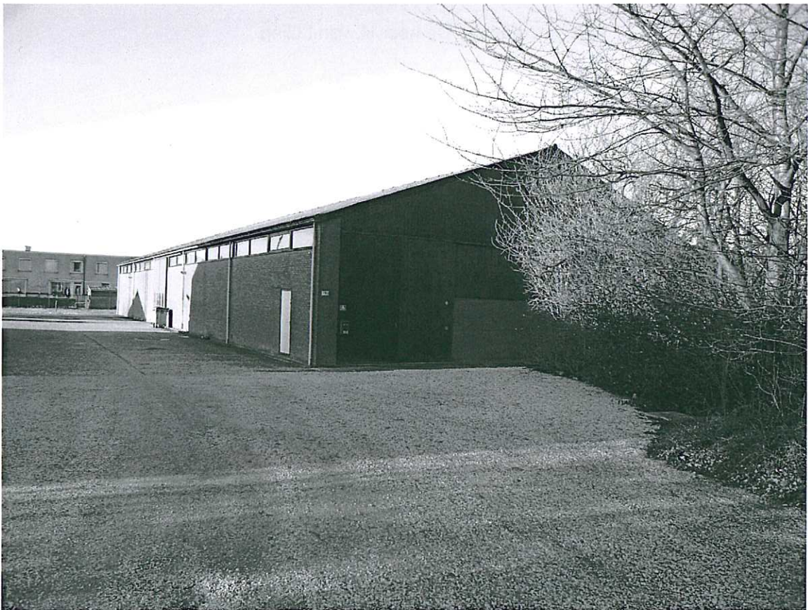
Hoofdweg 793-795 (landbouwschuur) te Hoofddorp
