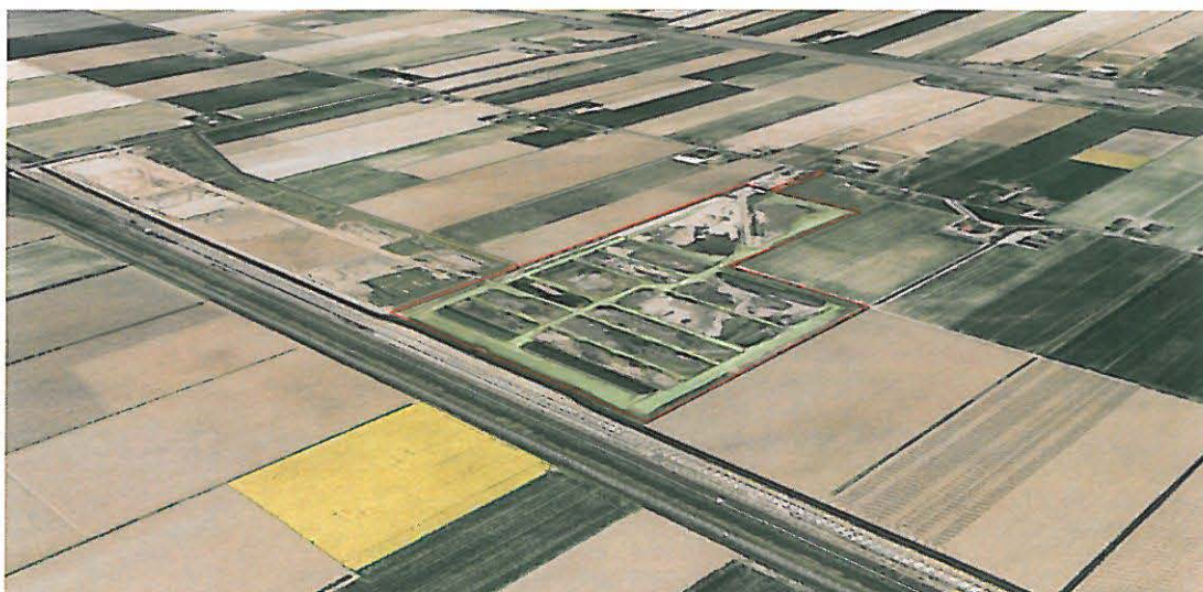
Bestaande situatie met rood omlind het baggerdepot op grondgebied van het Hoogheemraadschap van Rijnland
