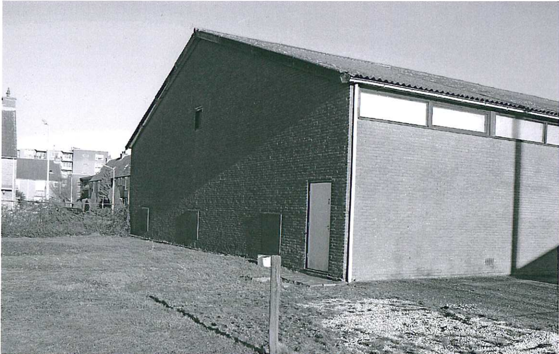
Foto 3: Gezicht vanuit westzijde op de achterzijde van de landbouwschuur.
