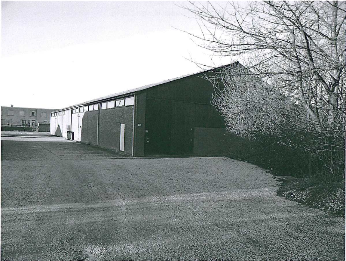
Hoofdweg 793-795 (landbouwschuur) te Hoofddorp
