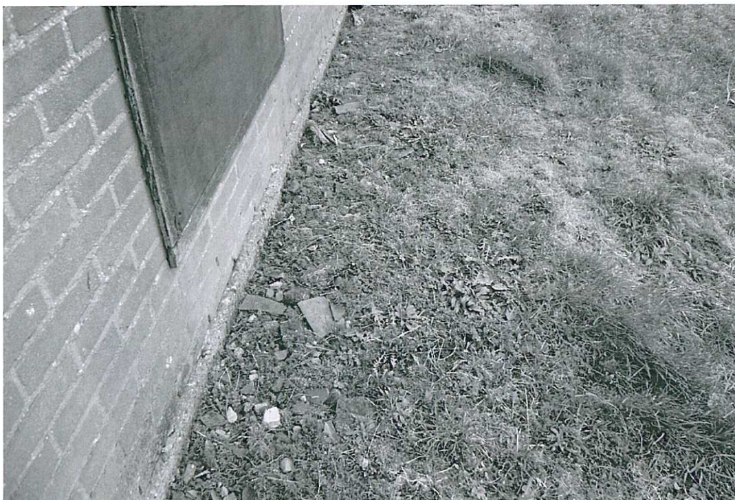
Foto 4: Gezicht op de asbesthoudende fragmenten op de bodem achter de landbouwschuur.
