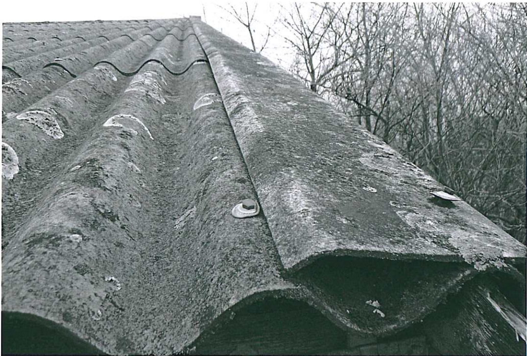
Foto 2: Gezicht op de asbesthoudende golfplaten en kantprofielen.
