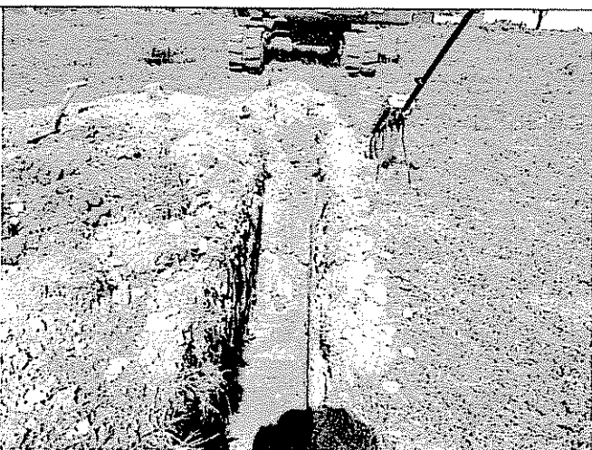
foto 5: sleuf t.b.v. asbestonderzoek
