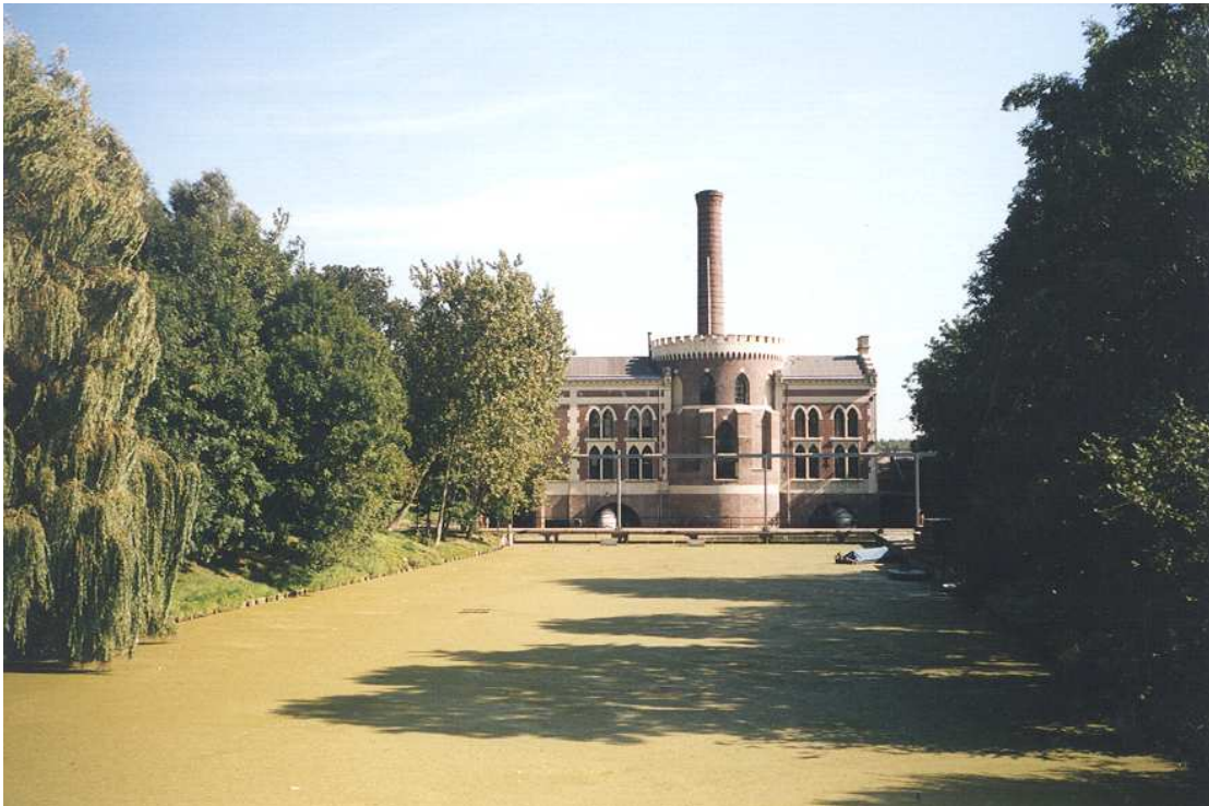
Figuur 2.1 Gemaal Lijnden
