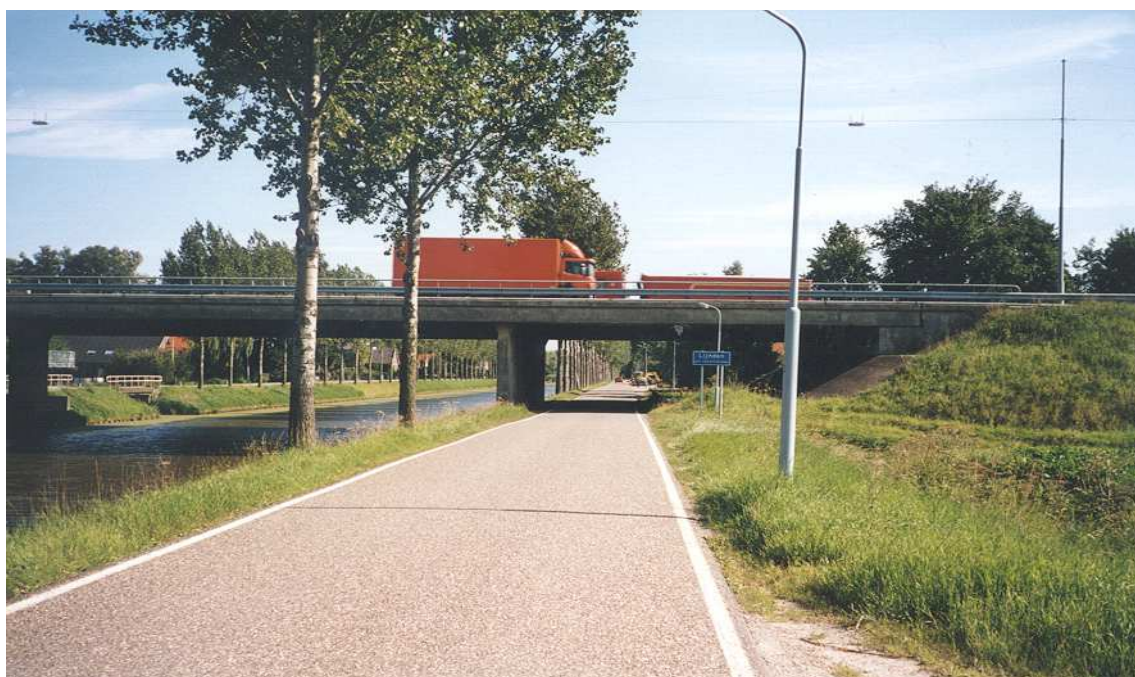
Figuur 2.3 Brug van de A9 over Hoofdvaart
