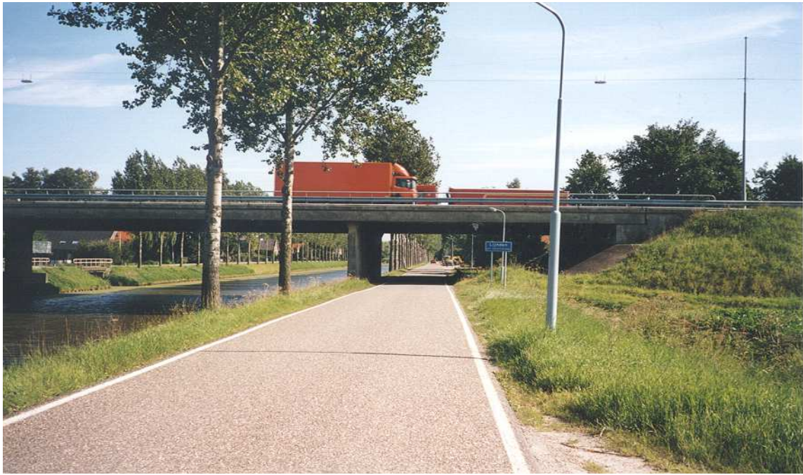
Figuur 2.3 Brug van de A9 over Hoofdvaart
