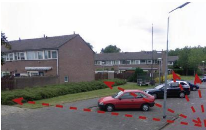
Figuur 2.4 Kuiperlaan; geen wandwerking.
