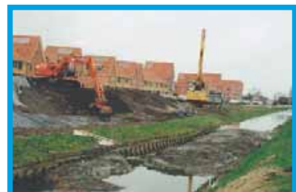
Op en nabij plekken waar de bodem is verstoord ontstaan regelmatig wellen en opbastingen van brak water. Dit gebeurde bijvoorbeeld bij de bouw van Getsewoud.
