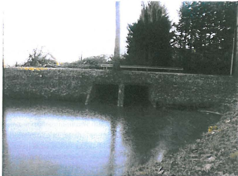
Afbeelding 2: Duiker b onder de Kromme Spieringweg bestaande uit twee kokers (huidige situatie bij winterpeil 68% lucht – 32% water)
