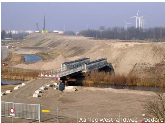
Aanleg Westrandweg - Osdorp
