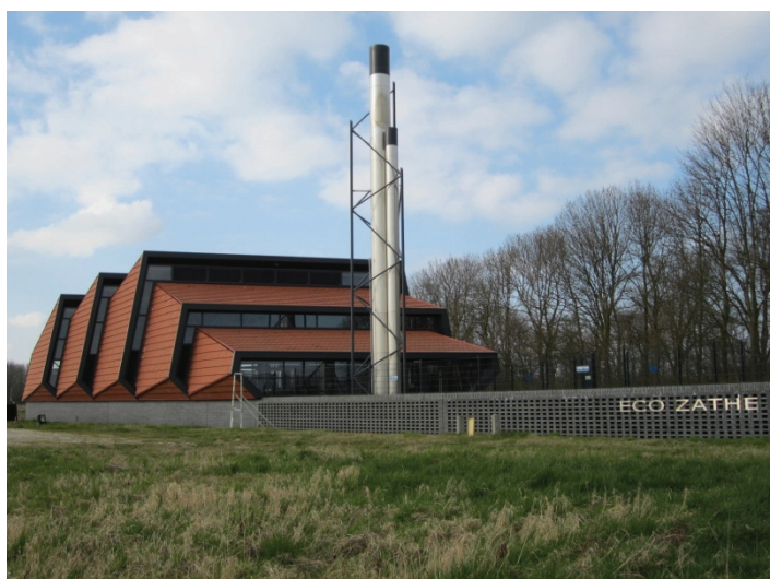
Afb: de biogas-WKK centrale in de wijk Zuidlanden te Leeuwarden levert warmte aan 700 woningen. Het biogas ontstaat door mestvergisting bij een veehouderij op 5 km afstand van de woonwijk
