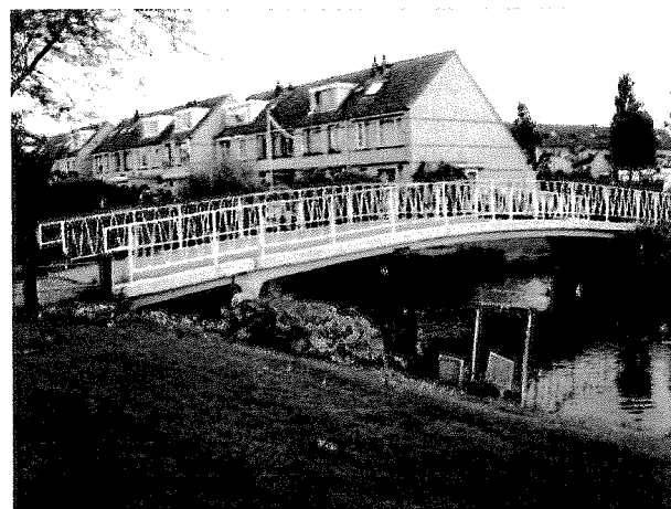
Valckslootlaanbrug, Hillegom (gemeentelijk) Bouwjaar 1971 Betonnen liggers, overspanningen 1,5 m. en 2 x 2,5 m.
