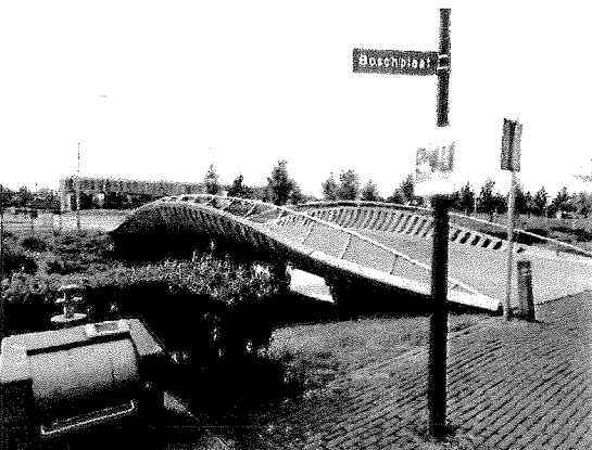
BR0256: Overzichtfoto. Onderhoudsstaat: 'Redelijk' (score: 3).
