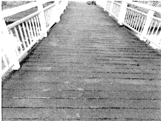
BR0148: Overzichtfoto. Onderhoudsstaat: 'Redelijk' (score: 3).
