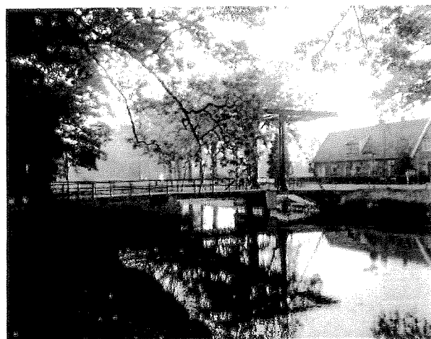
Scherpenbergweg, Apeldoorn (gemeentelijk) Bouwjaar 1941 Ophaalbrug met betonnen aanbruggen, overspanning ca. 5 m. en stalen val.
