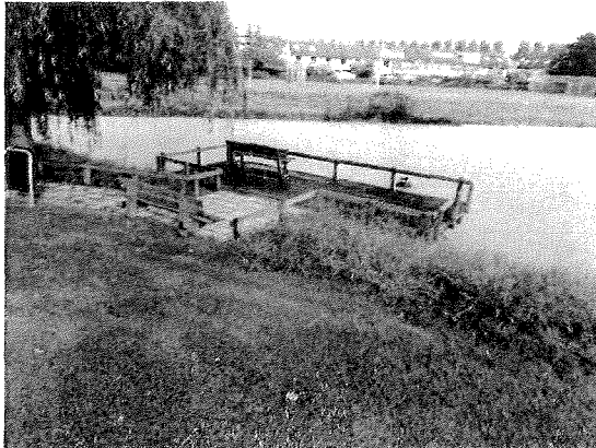
ST5010: Overzichtfoto. Onderhoudsstaat: 'Slecht' (score: 5).
