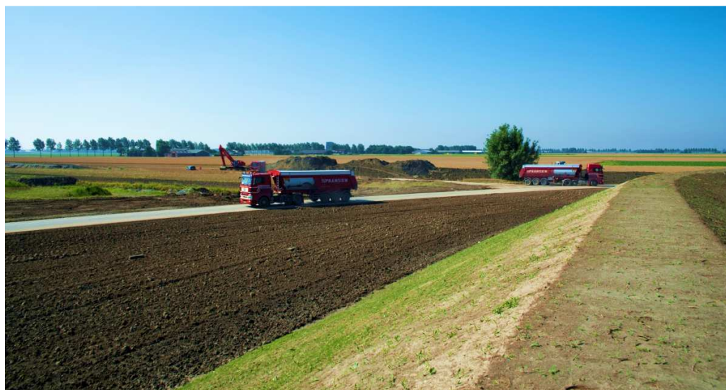
Aanleg grondwal Pioniers en verhoogde parklaag in deelgebied 1
