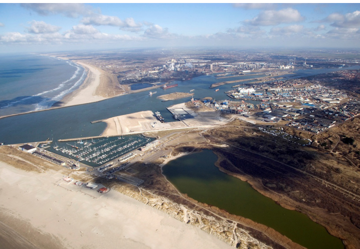
Haven- en industrieel complex IJmond
