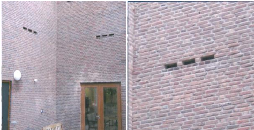
Mogelijkheden voor permanenten vleermuisvoorzieningen in de spouwmuur
